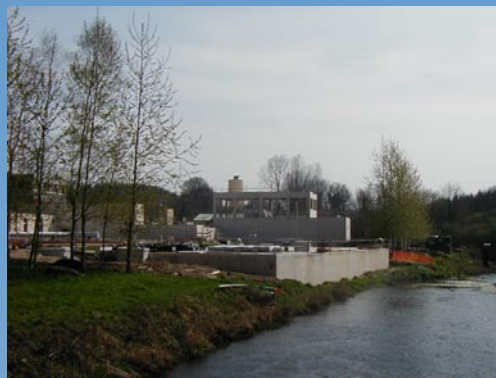
Kerne Uhel- pompage sur le Blavet
